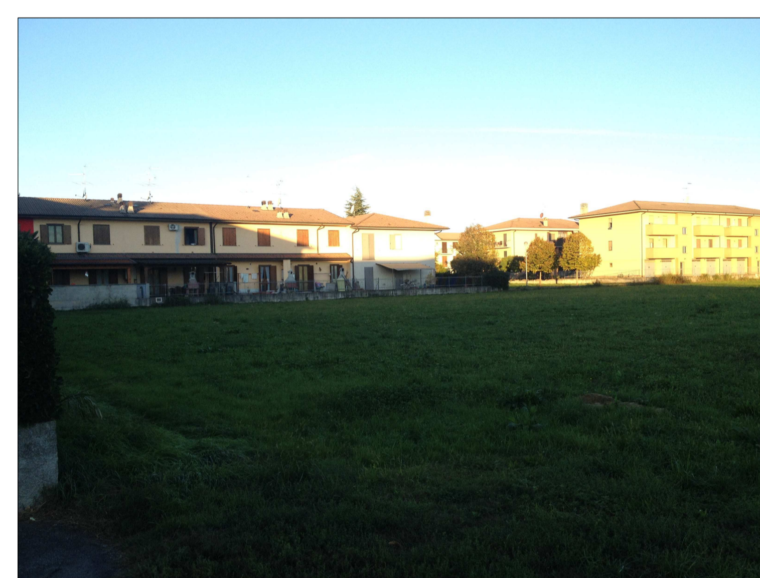
AREA VISTA DA SUD
